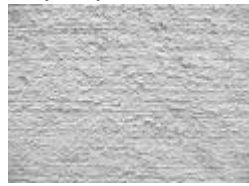
Hormigón de rugosidad media
